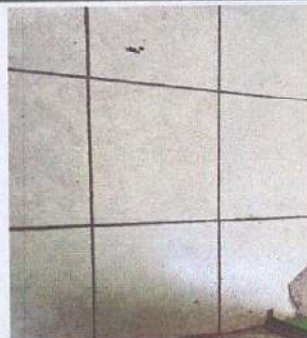
Foto 4: Sustitucion de piso cerámico en mal estado (rajaduras y levantado) por piso cerámico en cocina y corredor de cocina
