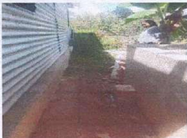
Foto1: Reparación de ple de cimentación de aula de lamina (escarificación de talud de tierra)
