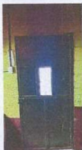
Foto 5: Mantenimientos a puertas de metal lijado y aplicación de pintura
