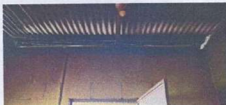
Foto 3: Sustitucion de Lamina y estructura en cocina por daños de oxido
